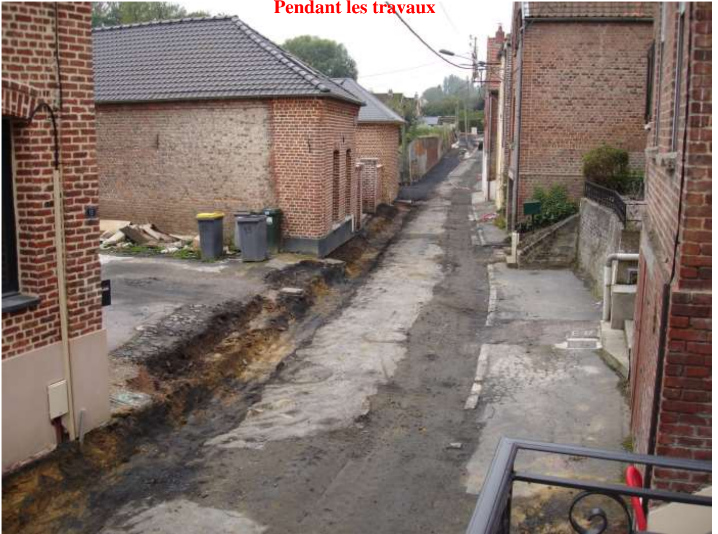
La rue après les travaux
