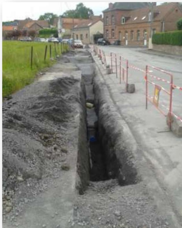
Travaux de branchement et pose de conduite d'eau potable rue de la Gare
