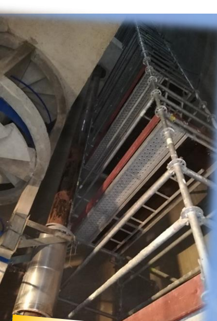
Vue interne échafaudage
