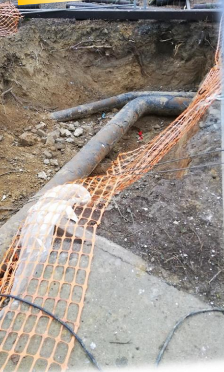
Contrôle des tuyauteries enfouies et datant de 1958
