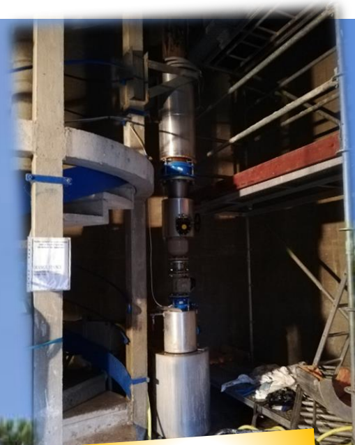
Réfection des tuyauteries et des composants.
